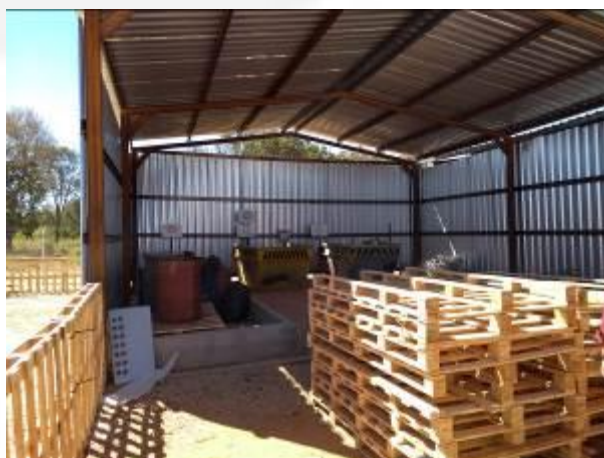
Foto 02. Galpão de Armazenamento de resíduos
