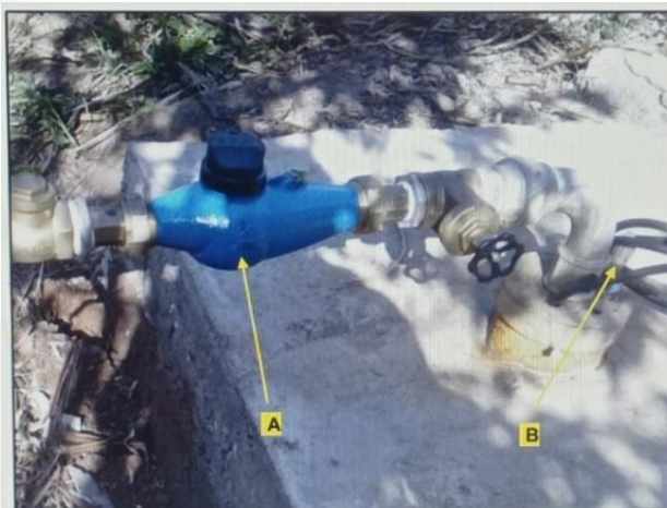
Foto 04 – Poço com hidrômetro
