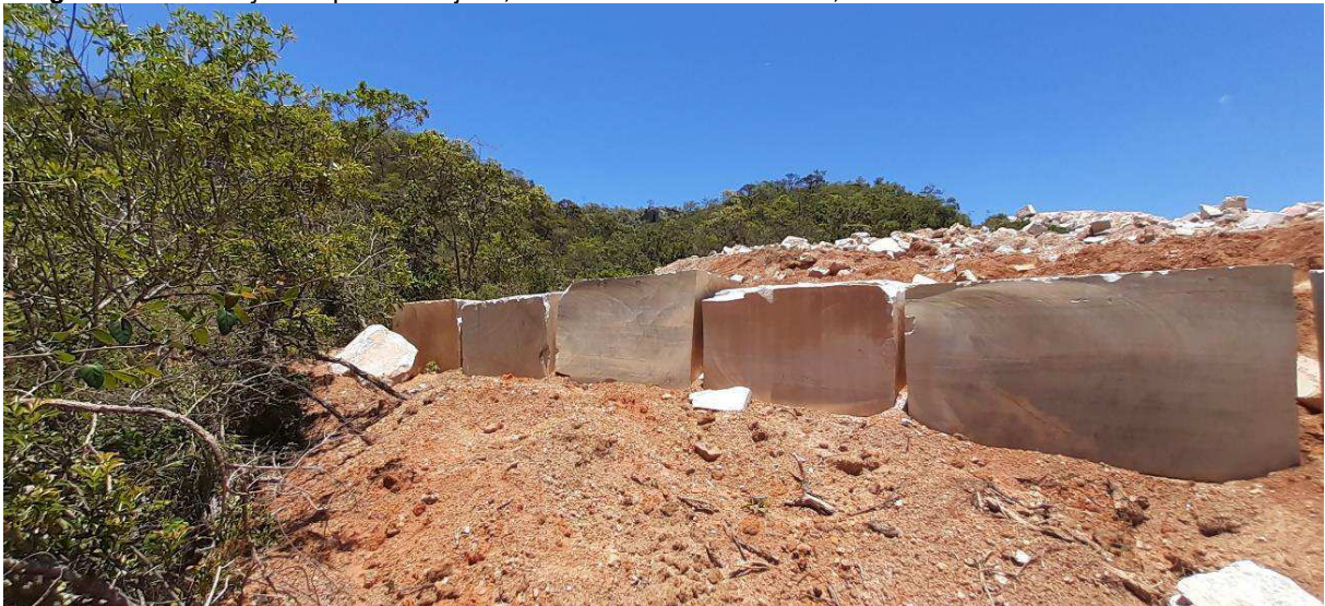
Imagem 03: Contenção da pilha de rejeito, coordenadas: 15°20'21.26"; 42°35'5.62".
