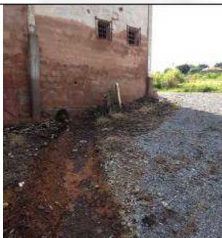
Foto 09. Vista do fundo dos 02 banheiros, tubulação enterrada no solo e canal no solo por onde escoar a água pluvial.
