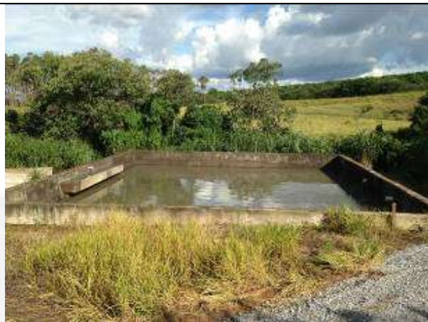
Foto 12. Vista do tanque identificado como “tanque dosador – tanque de oxigenação”, no entanto, desprovido de aeradores.
