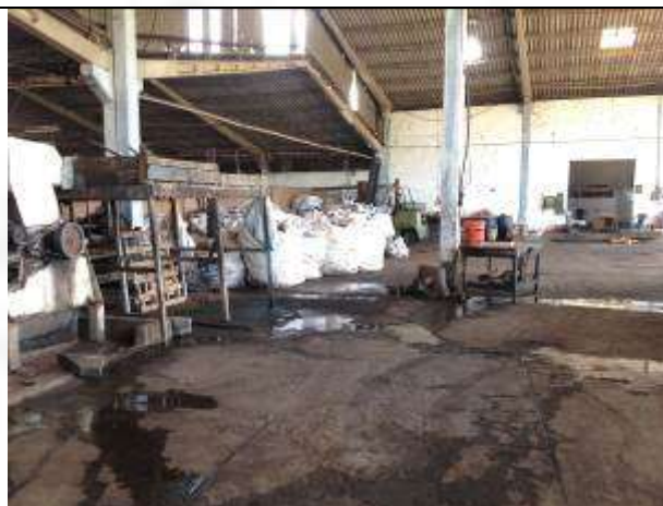
Foto 08. Vista parcial da área do galpão de produção, com água acumulada devido à entrada de água de chuva pelo telhado bastante deteriorado.
