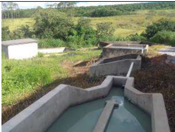
Foto 11. Vista parcial da ETE: calha parshall seguida de 02 tanques de decantação, que deságuam no “tanque dosador – tanque de oxigenação”.
