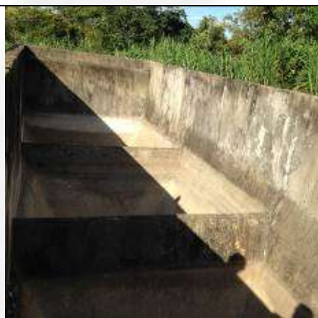
Foto 13. Decantador secundário vazio e instalado do lado do “tanque dosador – tanque de oxigenação”.
