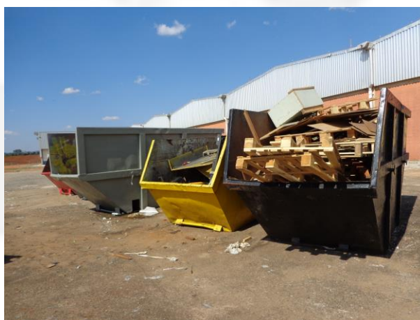
Caçambas de armazenamento temporário de resíduos inertes
