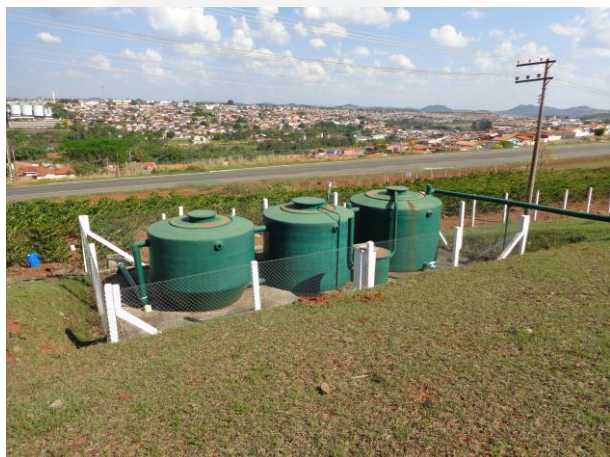
Estação de tratamento de efluente sanitário
