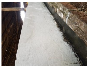
Figura 5: Recolhimento de Efluente nas baías
