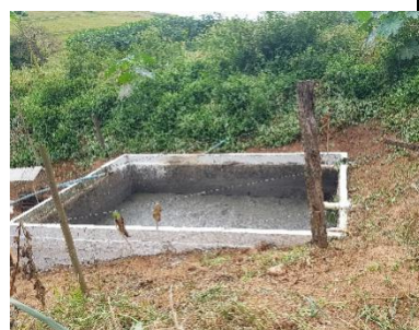
Figura 9: Caixa de passagem - pós tratamento de efluente
