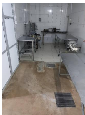
Figura 2: Sala de Preparo - Ralos com orientação para sistema de tratamento de efluentes
