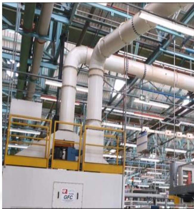
Foto 02. Lavadora da área de motores e sistema de exaustão
