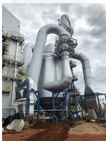
Foto 03. Lavador de gases da nova caldeira
