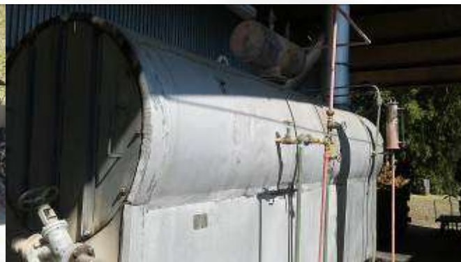
Foto 3 – Caldeira a lenha em funcionamento.
