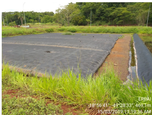
Figura 6: Tubos geotêxteis contendo lodo desidratado.
