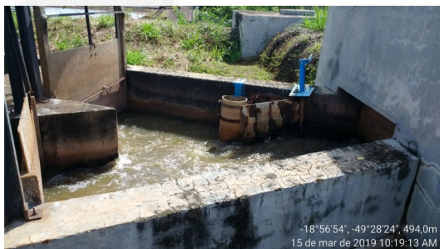
Figura 1: Entrada do esgoto bruto.
