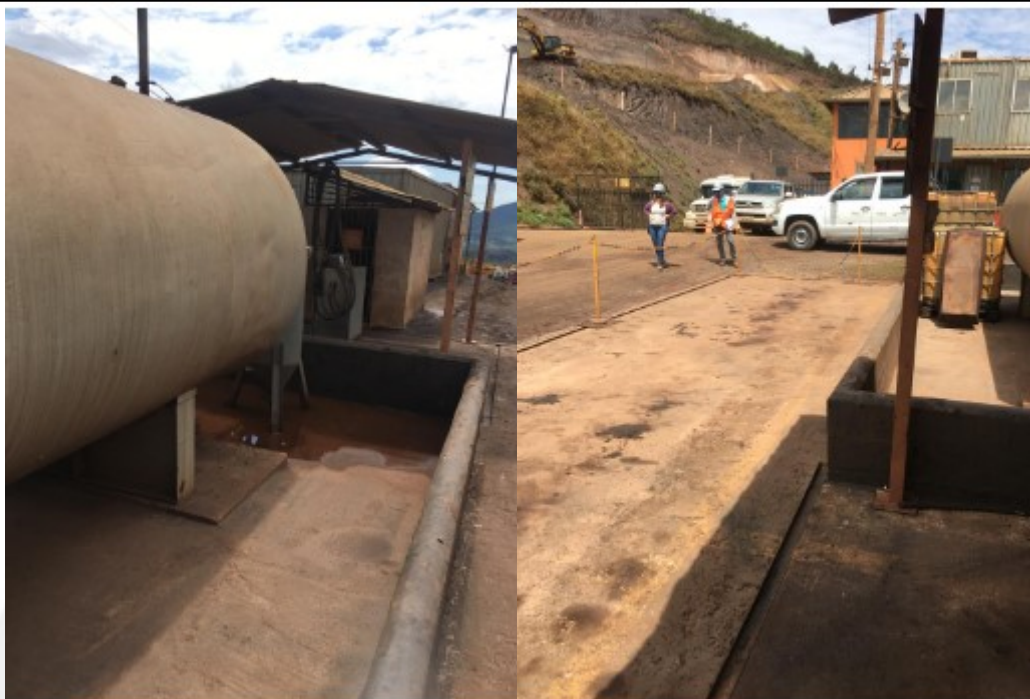
Figura 2.2.1.4.3. Ponto de abastecimento de combustível com bacia de contenção, piso impermeabilizado e canaleta de limite direcionada para CSAO.
