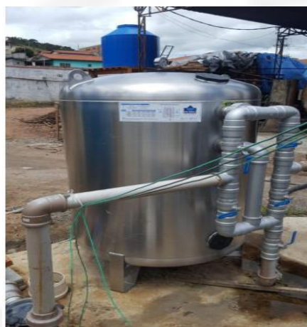
Foto 04 - Implantação de filtro INOX ASI 304 – sistema MUVA
