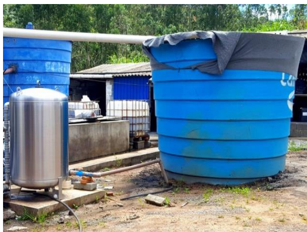
Foto 05 - Implantação CAIXA 20.000 litros e filtro INOX ASI 304
