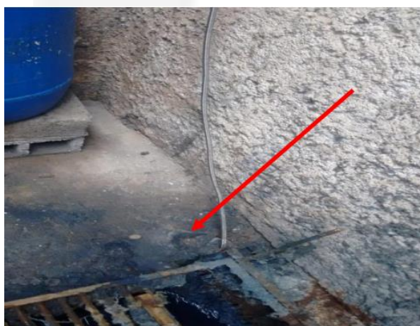
Foto 03 - Dispositivo de entrada do ozônio no efluente industrial bruto
