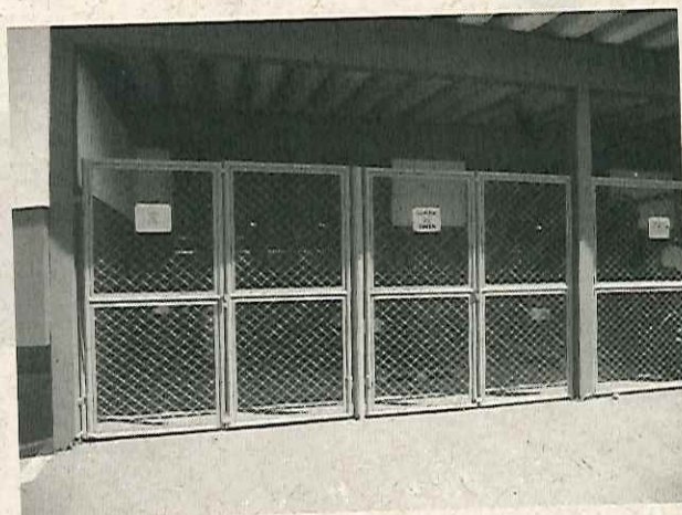
Foto 04. Armazenamento de resíduos.
