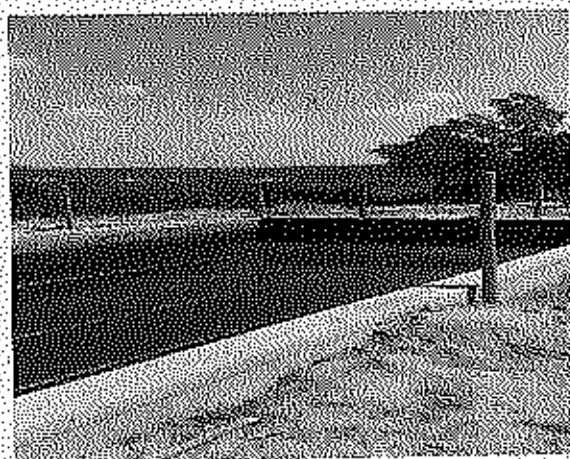
Foto 01. Bacia de contenção das águas residuárias.
