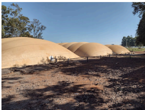
Biodigestores /tratamento de efluentes
