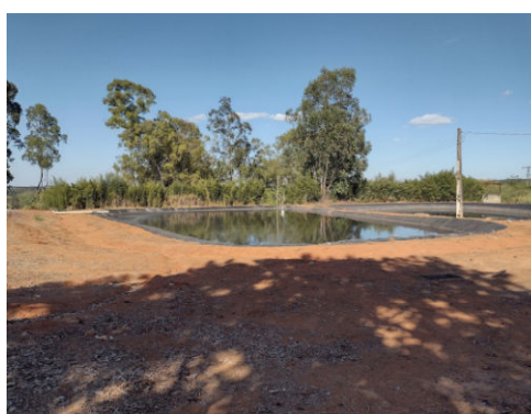
Lagoas de tratamento de efluentes
