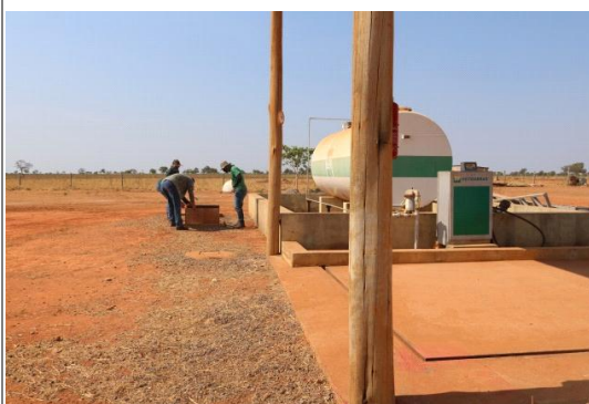
Foto 03. Unidade de abastecimento de combustível – tanque aéreo.
