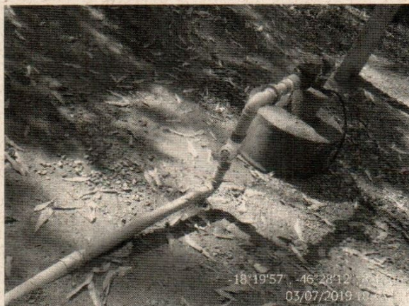
1 entre os 4 Poços Tubulares com hidrômetro e horímetro
