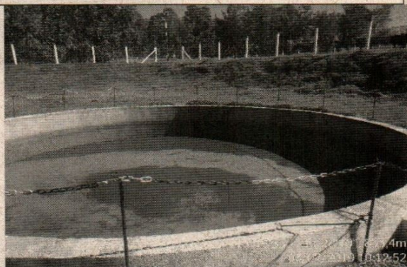
Tanque equalizador
