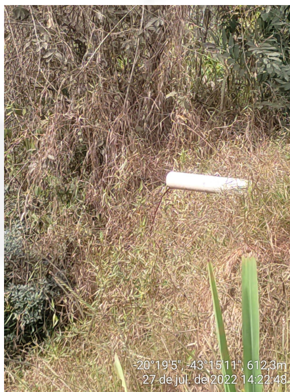
Figura 04: Local de lançamento do chorume proveniente da salga de couros no curso d'água. Fonte: Vistoria – 27/07/2022.
