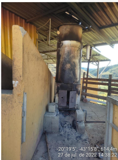
Figura 02: Caldeira à lenha do empreendimento. Fonte: Vistoria – 27/07/2022.
