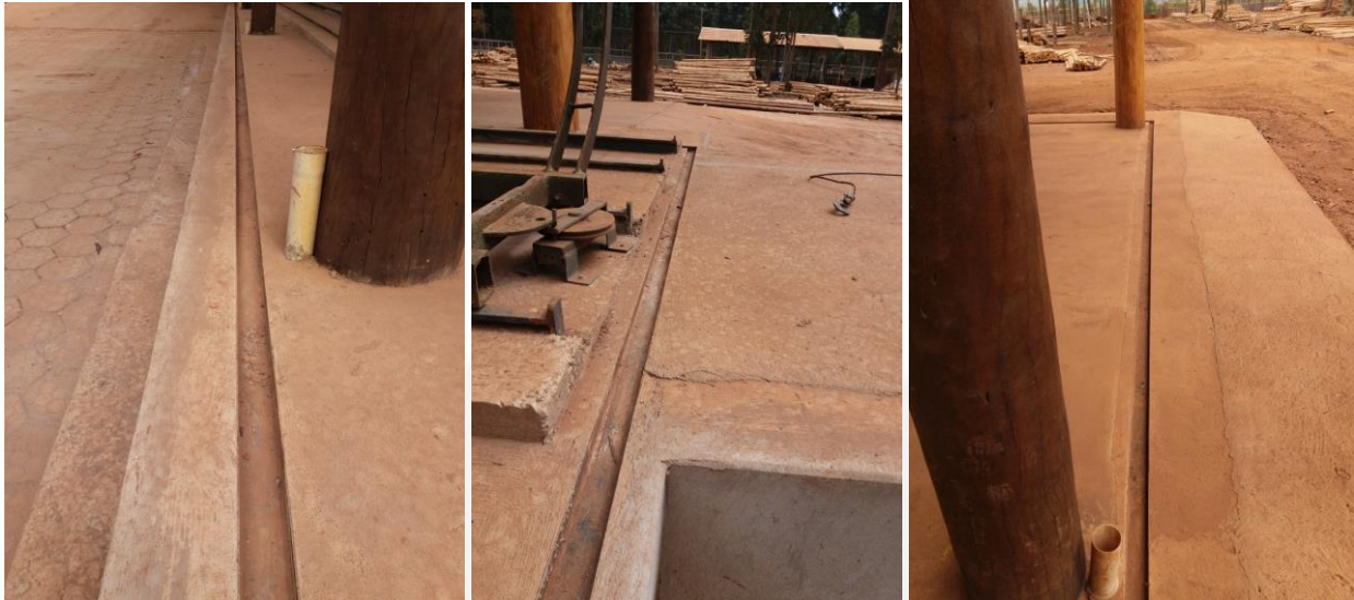
Fotos 6, 7 e 8: Sistema de drenagem (canaletas) instalado no perímetro da usina.
