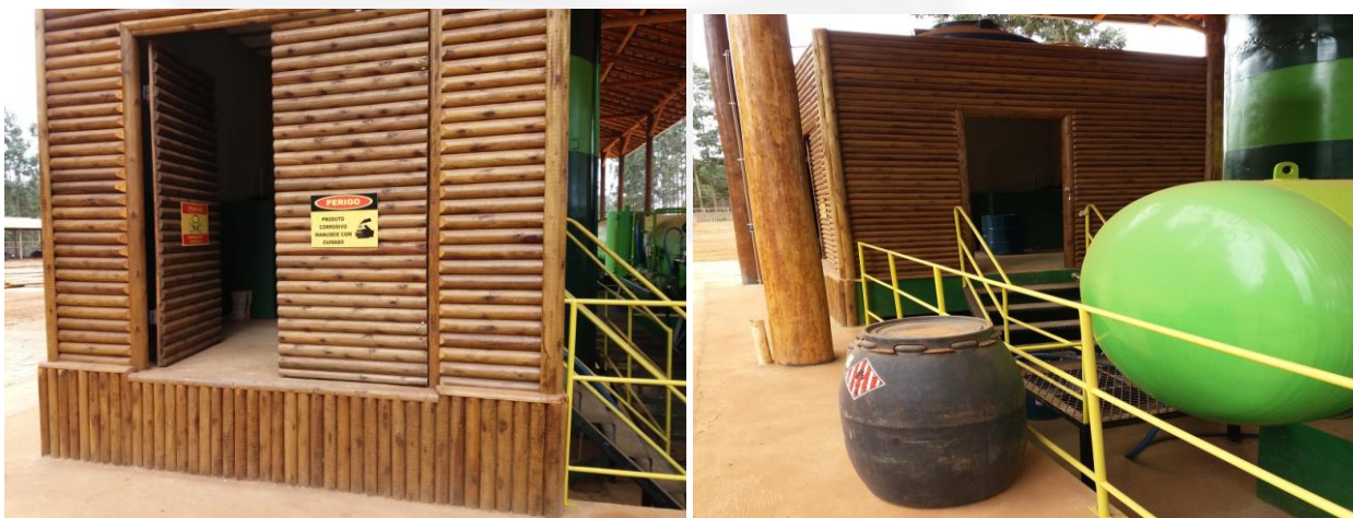
Fotos 11 e 12: Depósito de insumos (preservativos de madeira e neutralizantes).
