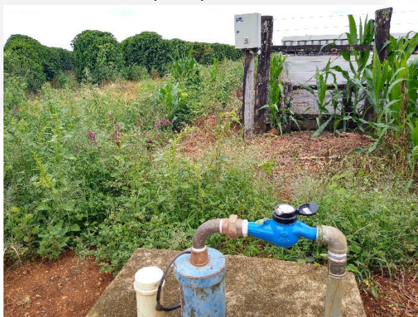
Poço Tubular com hidrômetro e horímetro
