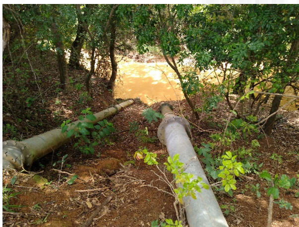
Tubulação para captação superficial
