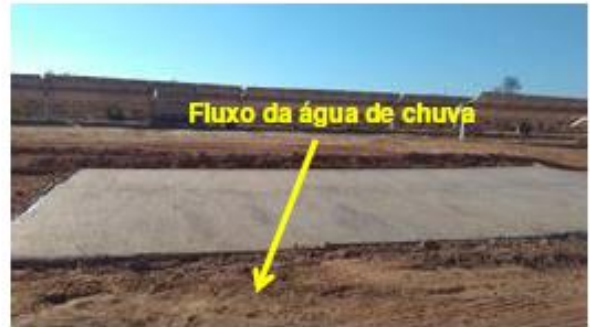
FOTO 2.2: CONSTRUÇÃO DAS LAGES DE CONCRETO EM PONTOS DE CONVERGÊNCIA DA ÁGUA PLUVIAL.
