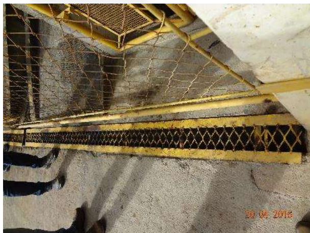
Fig.5 – Canaletas de condução de efluentes e caixa SAO, não há descarte dos efluentes e sim recirculação dos mesmos.
