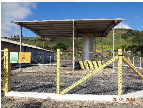
Fig.7 – Posto de abastecimento, com sistema de contenção de vazamentos, coberto e piso impermeável, com caixa SAO para o tratamento dos efluentes gerados na pista de abastecimento, não há lançamento de efluentes, o mesmo é recirculado.
