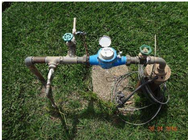
Fig. – Horímetro e Hidrômetro instalados nos postos de coordenadas 21° 16' 26,17"S e 42° 03' 31,49"W.
