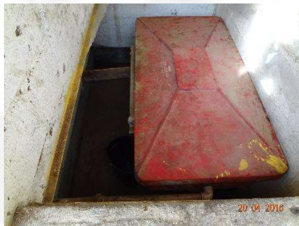
Fig.5 – Canaletas de condução de efluentes e caixa SAO, não há descarte dos efluentes e sim recirculação dos mesmos.
