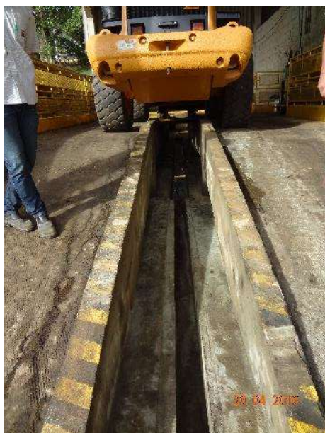
Fig. 4– Lavador de máquinas coberto e sistema de recirculação de água do lavador, não há uso de produtos químicos e sim água aquecida.
