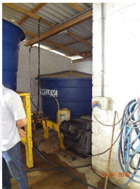
Fig. 4– Lavador de máquinas coberto e sistema de recirculação de água do lavador, não há uso de produtos químicos e sim água aquecida.
