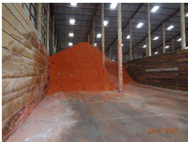
Fig.8 – Caixotões cobertos com piso impermeável.
