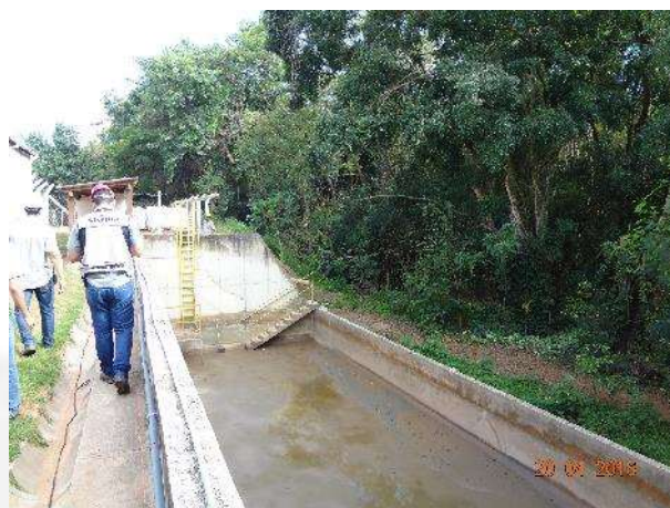
Fig.10 – Caixa de sedimentação, toda a água acumulada é destinada a irrigação das áreas verde do empreendimento assim como umectação das vias.
