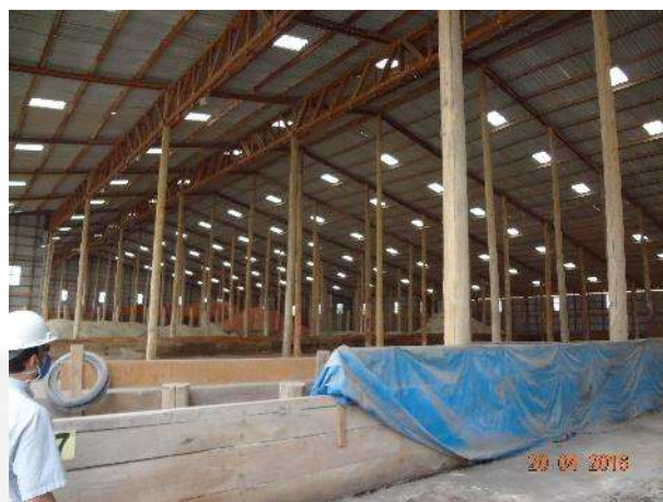
Fig.8 – Caixotões cobertos com piso impermeável.
