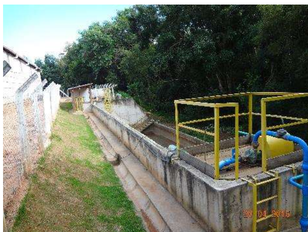
Fig.10 – Caixa de sedimentação, toda a água acumulada é destinada a irrigação das áreas verde do empreendimento assim como umectação das vias.
