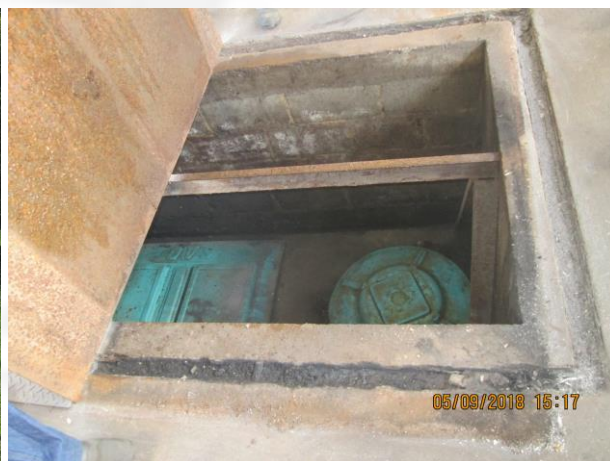
Foto 8: Caixa separadora de água e óleo.
