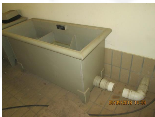
Foto 10: ETE tamponada galvanoplastia.
