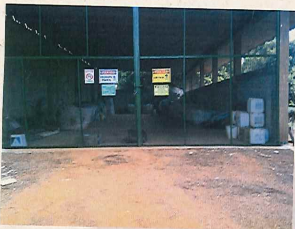
Figura 17. Depósito temporário de embalagens vazias de agrotóxicos
