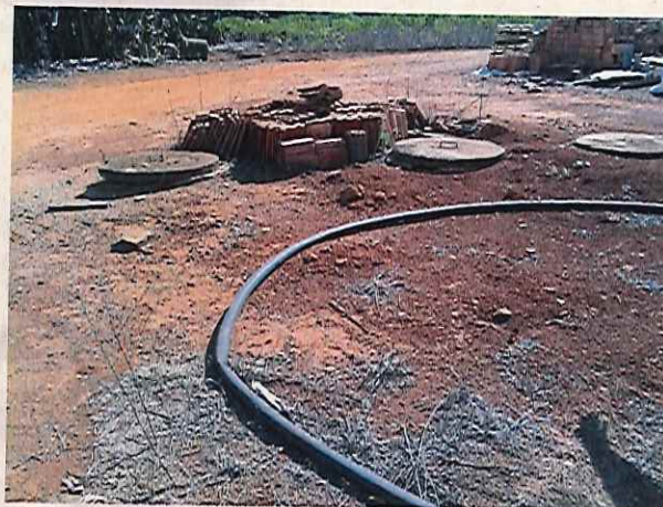
Figura 20. Sistema de tratamento de esgoto sanitário (fossa séptica seguida de sumidouro)
