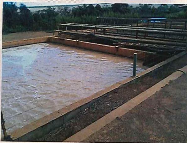
Figura 22. Sistema de reaproveitamento das águas residuárias oriundas do beneficiamento de produtos agrícolas
