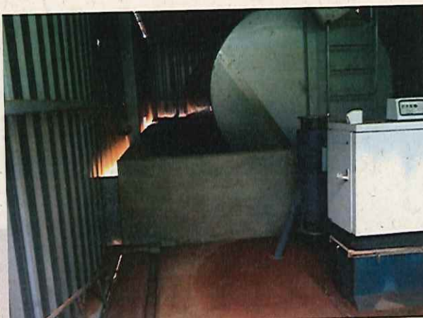
Figura 12. Tanque de combustível
