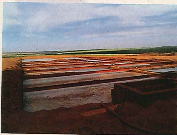
Figura 21. Lagoas de decantação (sistema de tratamento das águas residuárias oriundas do beneficiamento de produtos agrícolas)
