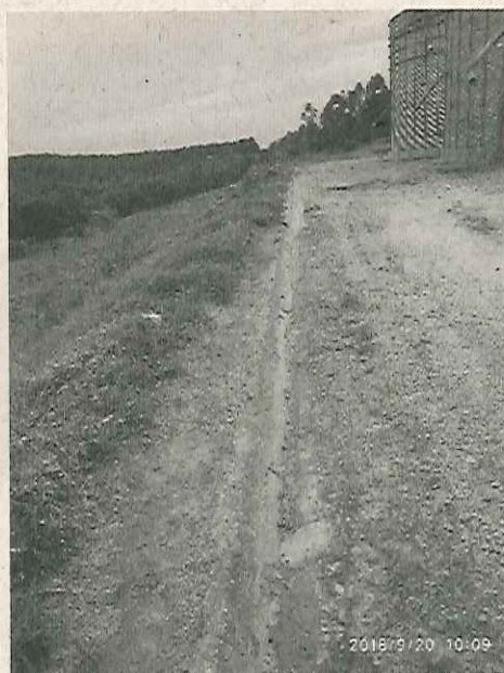
Foto 06 - Drenagem de águas pluviais
