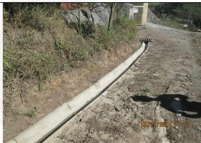
Foto 9: Canaleta de drenagem de água pluvial de via de acesso
