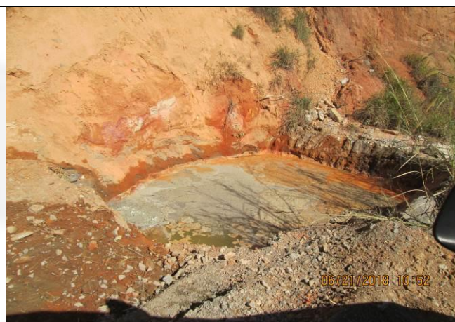
Foto 4: Bacia de decantação de sedimentos
