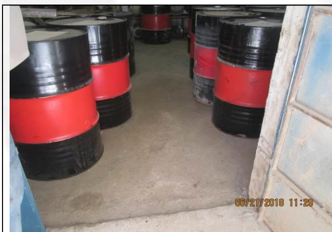
Foto 15: Depósito de óleo lubrificante com piso impermeabilizado e mureta de contenção de vazamento
