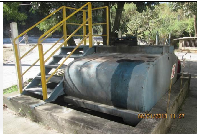
Foto 14: Tanque de óleo usado com bacia de contenção de vazamento
