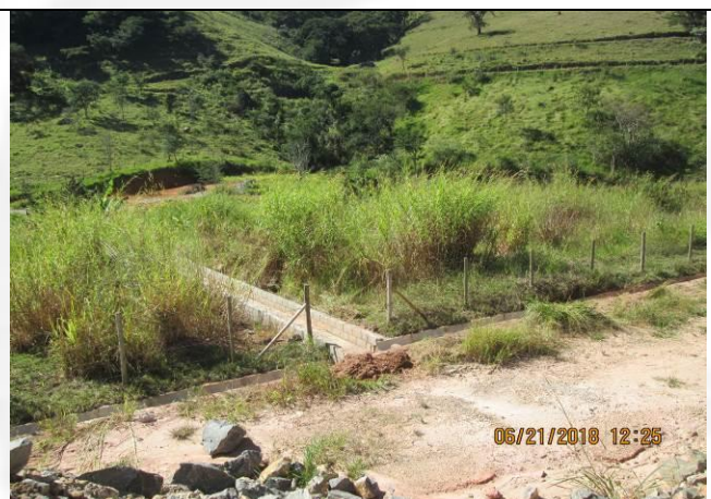
Foto 19: Drenagem pluvial da pilha de estéril Caeté
