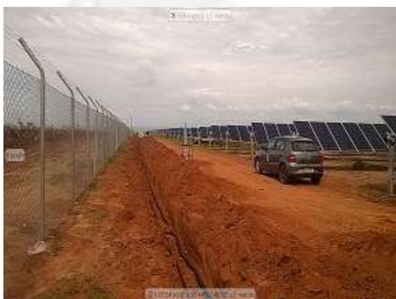
Foto 15. Cabos para monitoramento por câmeras de vídeo.
