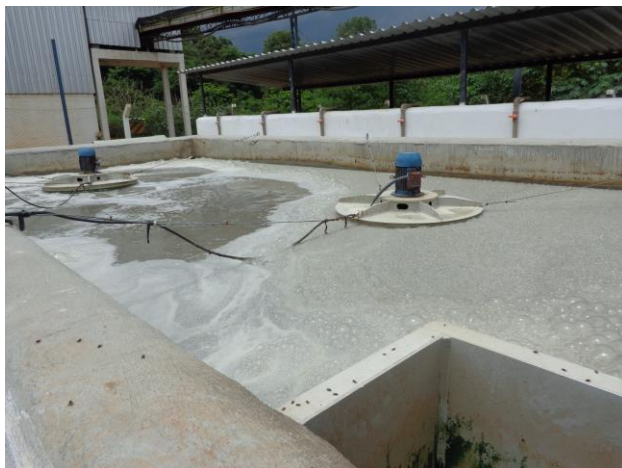
Foto 09. Tanque de aeração.
