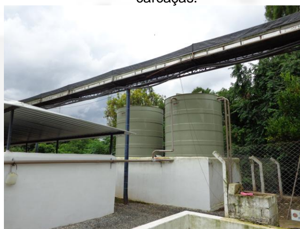
Foto 10. Tanques de equalização.
