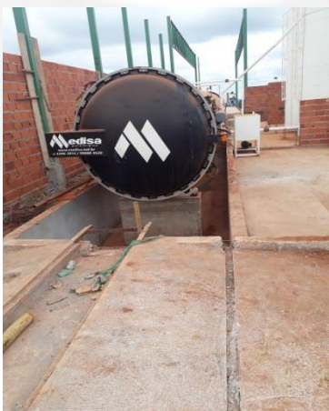
Fotos 7, 8 e 9 – Estrutura da autoclave em implantação e madeira a ser tratada.
