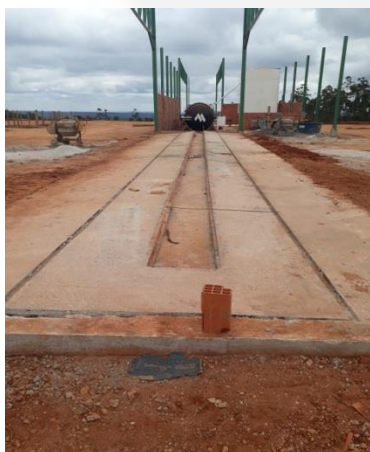
Fotos 7, 8 e 9 – Estrutura da autoclave em implantação e madeira a ser tratada.
