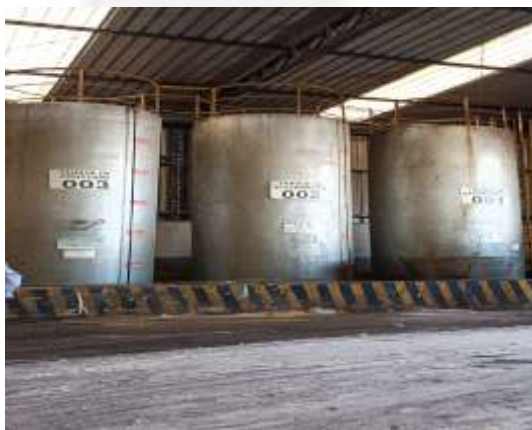
Foto 03. Tanques armazenamento resíduos líquidos.
