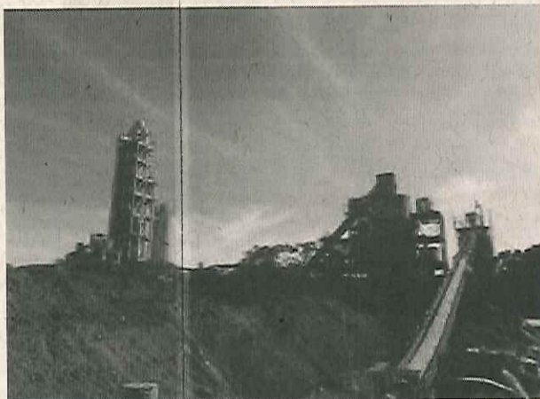
Foto 03. Da esquerda para a direita: Forno de clínquer, silo de clínquer e correia para transporte de matérias primas para produção de cimento.
