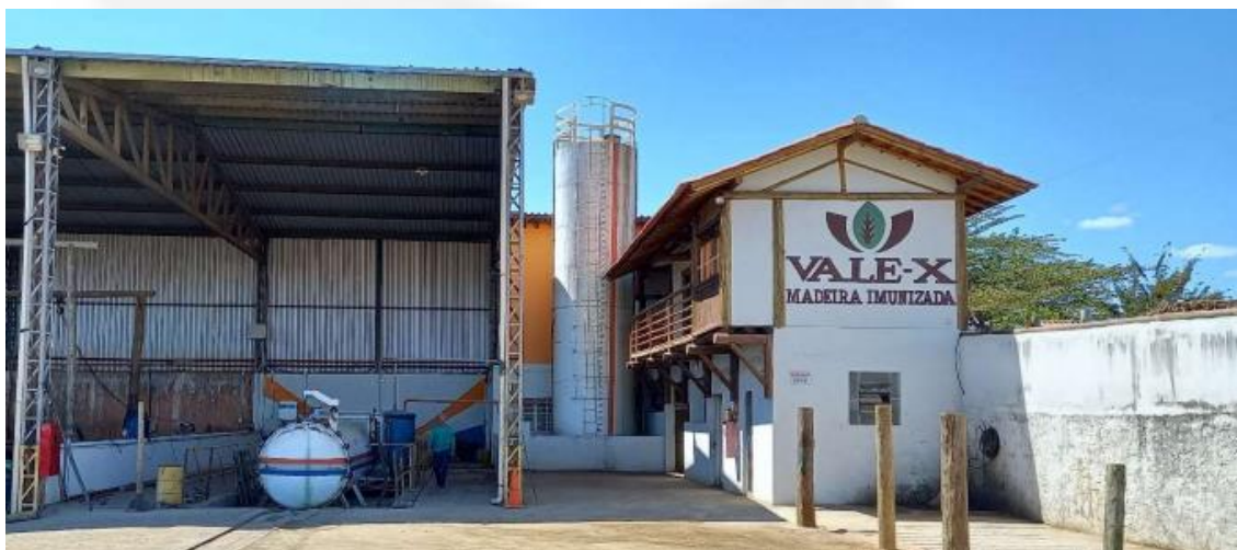
Foto 3: Autoclave fechada em tratamento, tanque de contenção, ao lado reservatório de mistura e escritório
