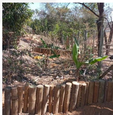
Foto 4: Paliçada para diminuir energia da água
