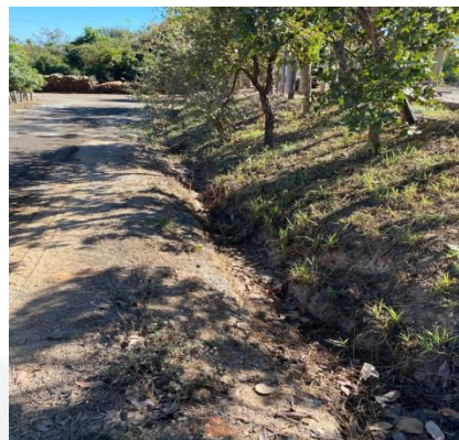
Foto 2: Canaleta de escoamento, talude com cobertura vegetal
