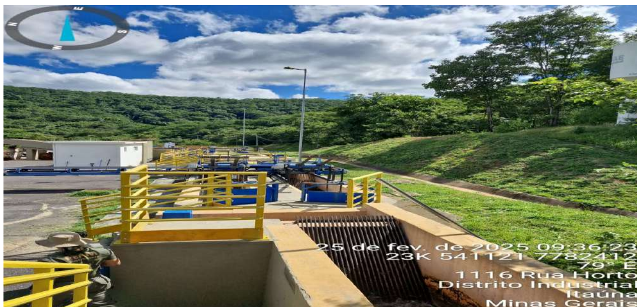
Figura 3 – Tratamento preliminar. Fonte: Equipe técnica da URA – ASF.
