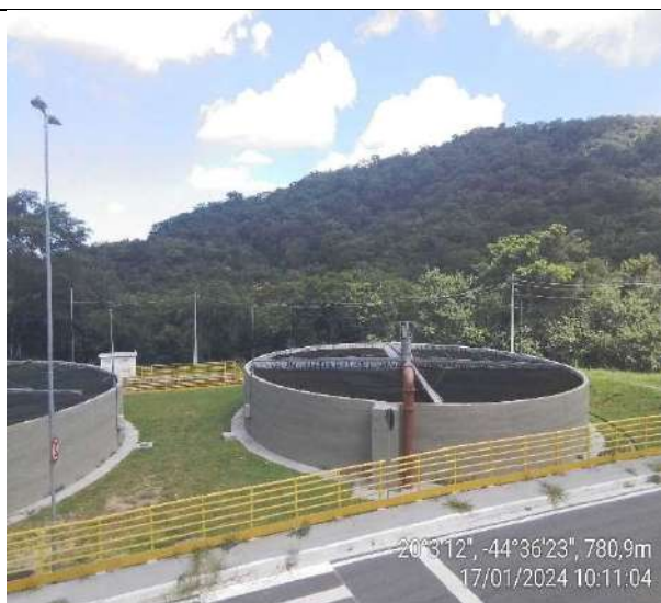
Foto 09. Filtro Biológico Percolador .
