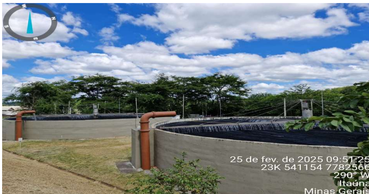
Figura 5 - Filtros Biológicos Percoladores. Fonte: Equipe técnica da URA – ASF.
