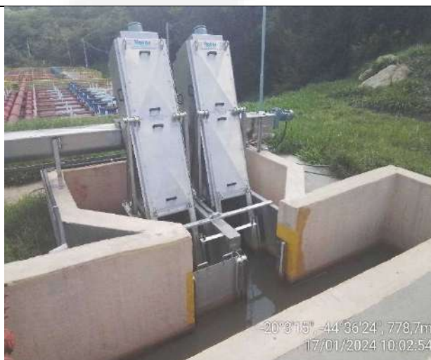
Foto 07. Tratamento preliminar (peneiras mecanizadas).
