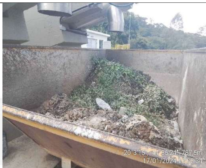
Foto 06. Armazenamento dos resíduos provenientes do tratamento preliminar.
