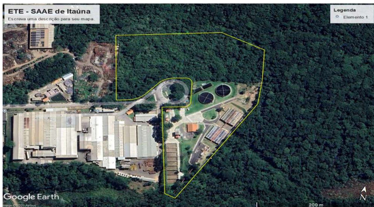
Figura 1 - Polígono referente a ETE do SAAE de Itaúna. Fonte: Autos do PA 3949/2024-Ecossistemas-SLA/Imagem Google Earth.
