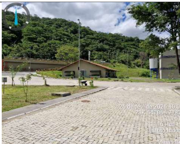
Foto 13. Vista parcial do empreendimento, destaque para a edificação (ao centro) onde fica situado o escritório, sanitários, laboratório e refeitório, bem como a edificação (a direita) que abriga a centrífuga do lodo.
