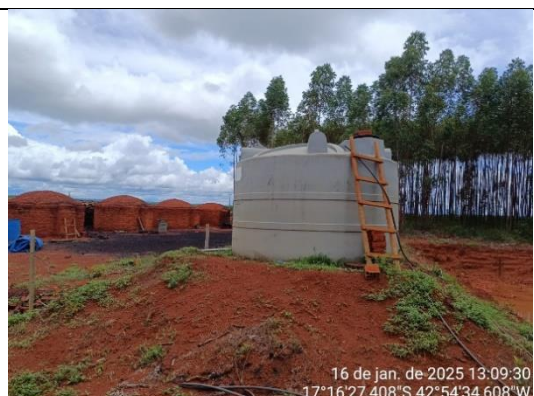
Foto 20. Caixa d'água de armazenamento de água fluvial
