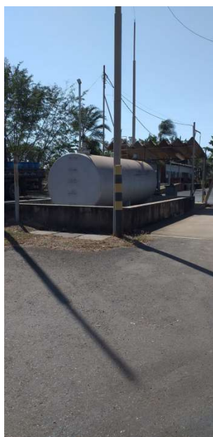
Foto 05. Tanque de armazenamento de combustíveis
