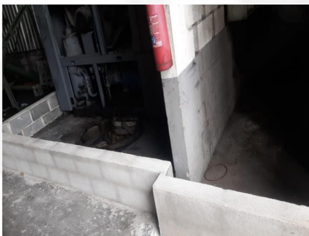
Foto 03: Bacia de contenção do compressor
