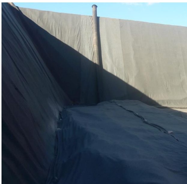
Foto 02. Drenos – testemunho e coleta de chorume
