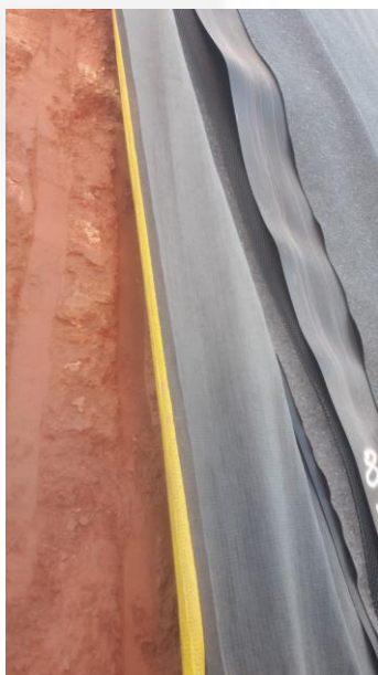
Foto 03. Camadas de impermeabilização
