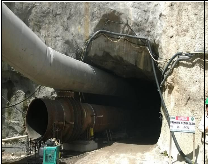
Foto 09: Saída do Túnel
