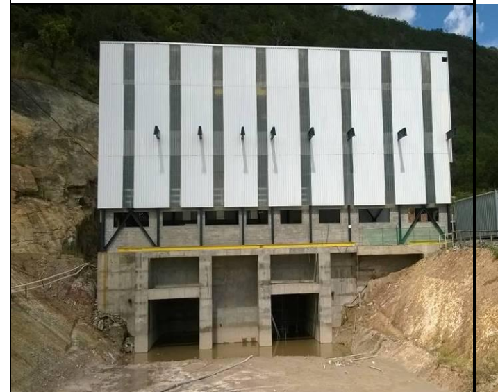
Foto 06: Casa de Força
