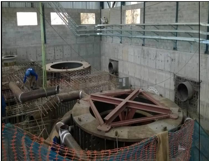
Foto 07: Casa de Força
