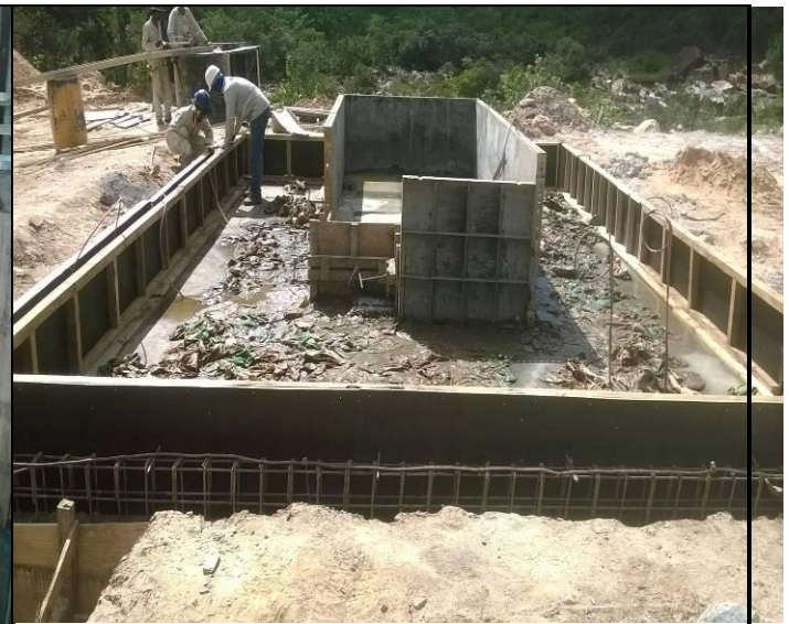
Foto 08: Subestação de Energia
