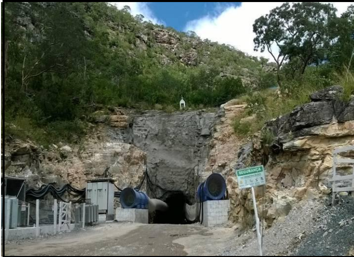
Foto 01: Janela do Túnel
