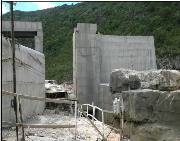
Foto 03: Muro do Barramento
