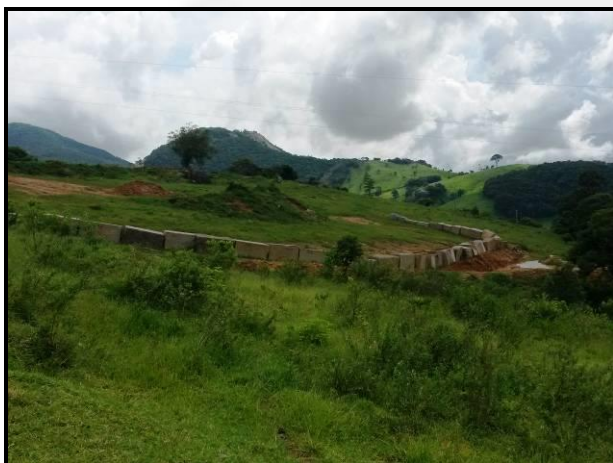
Foto 01. Área da pilha de rejeito/estéril com mudo de contenção no pé da pilha
