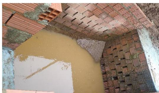
**Foto 04. Caixa de contenção de sedimentos**
