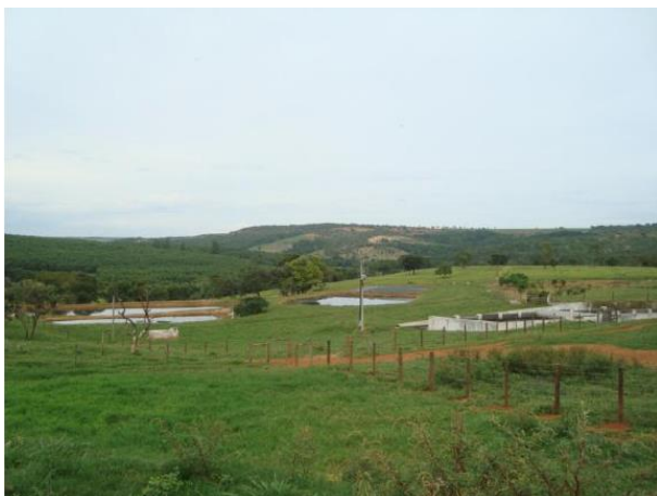
Foto 05. Print do relatório fotográfico acostado no processo - vista do local onde é feito o tratamento dos efluentes gerados na suinocultura, onde temos os tanques de decantação e as 4 lagoas de tratamento.
