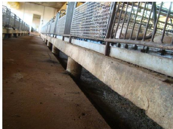
Foto 02. Print do relatório fotográfico acostado no processo - vista da parte traseira de um conjunto de gaiolas de maternidade - piso suspenso, o que facilita a limpeza e reduz o consumo de água.
