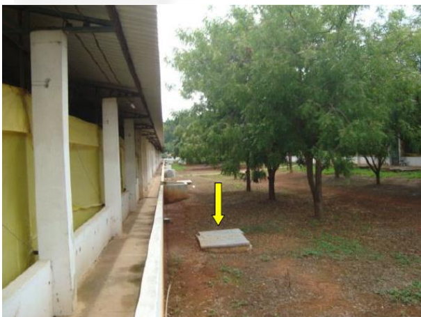
Foto 03. Print do relatório fotográfico acostado no processo - vista lateral de um galpão de criação de suínos, o qual possui beiral largo e em destaque uma caixa de passagem de efluentes.
