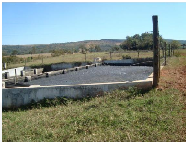
Foto 06. Print do relatório fotográfico acostado no processo - vista dos tanques de decantação dos efluentes, construídos de alvenaria. Todo o efluente é destinado para os tanques onde ocorre a decantação dos sólidos.
