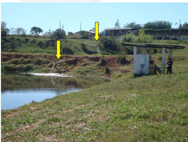
Foto 07. Print do relatório fotográfico acostado no processo - vista da sequência entre a 3ª e a 4ª lagoa, cuja altura do tubo auxilia na oxigenação dos efluentes.
