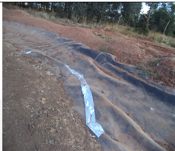
Figura 03 – Bacia de contenção e canaletas impermeabilizadas com PEAD para coleta de efluentes.
