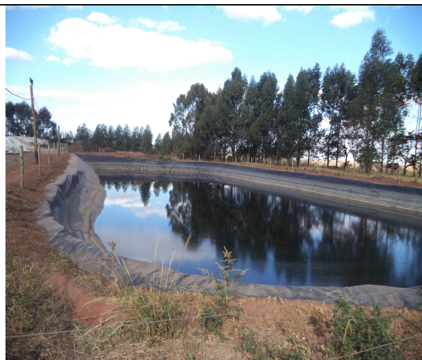
Figura 03 – Bacia de contenção e canaletas impermeabilizadas com PEAD para coleta de efluentes.
