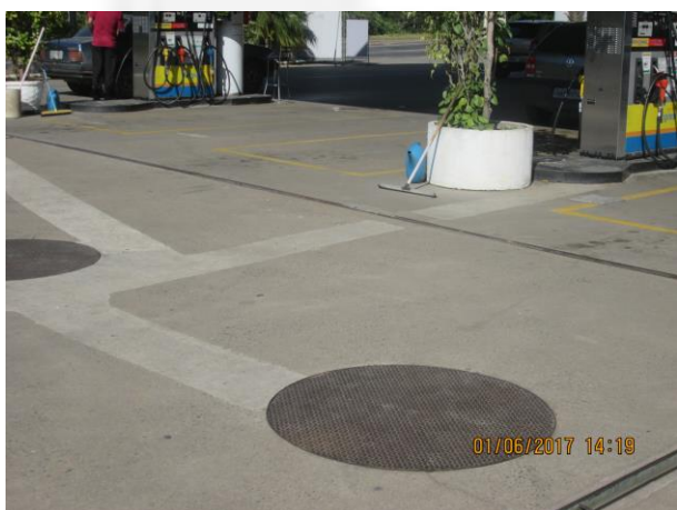
Foto 1 – Pista de abastecimento em concreto e com canaletas para direcionamento dos efluentes.
