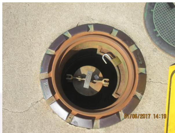
Foto 4 – Boca de descarga com SUMP.
