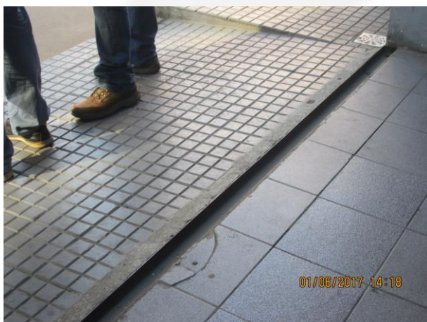
Foto 11 – Canaleta de direcionamento dos efluentes da troca de óleo.
