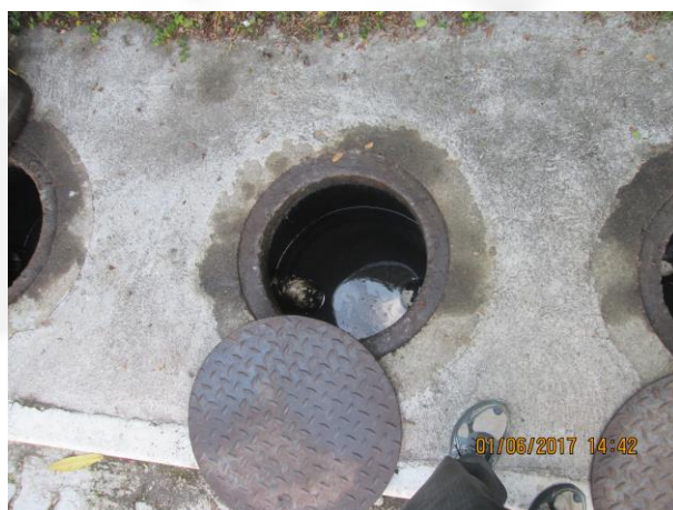
Foto 8 – Caixa SAO da pista de abastecimento de óleo Diesel.
