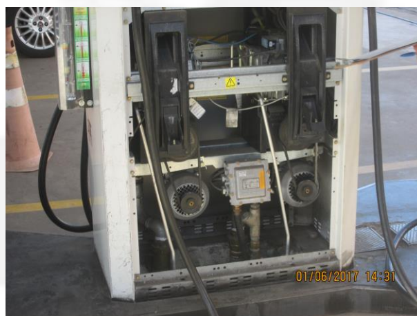
Foto 2 – Bomba de abastecimento com SUMP.
