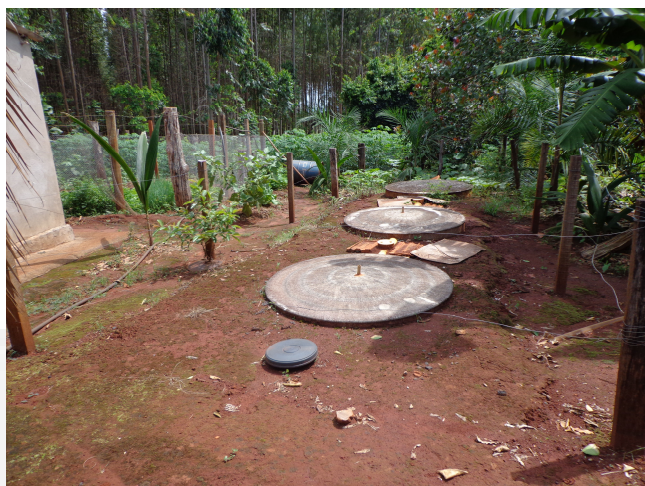
Foto 06. Fossa séptica biodigestora-sede
