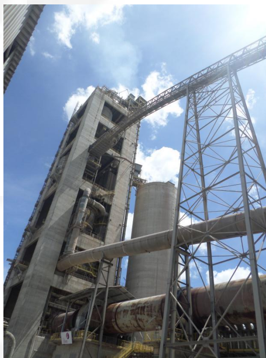
Foto 02. Vista da Linha 2 instalada, destaque para alimentação do Forno 2 através da Correia Transportadora
