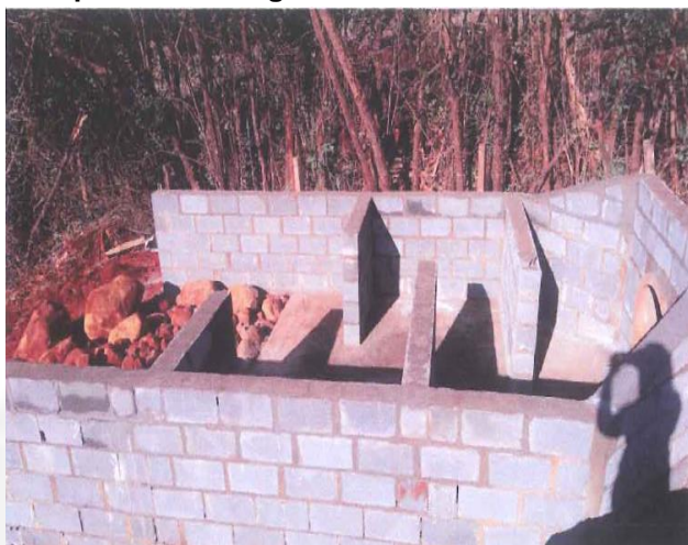
Figura 03 - Dissipador de energia construído na área da BT Construções
