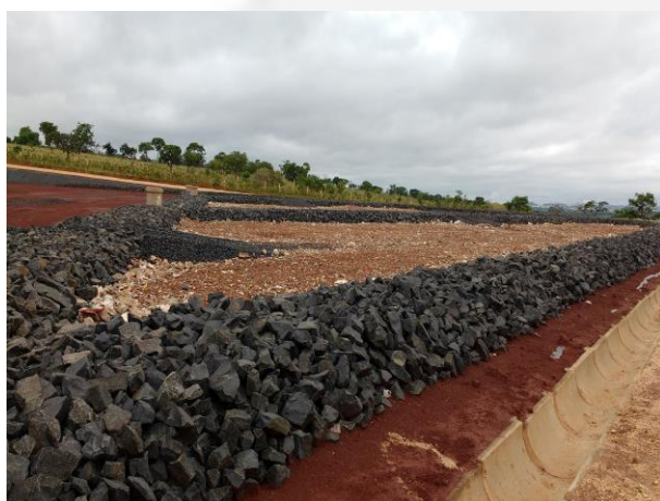
Foto 01. Sistema de drenagem de percolados e camada de RCC
