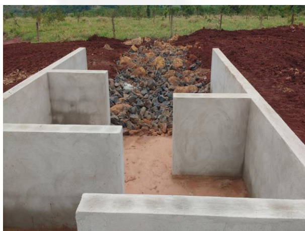
Foto 03. Dissipador de energia seguido por enrocamento
