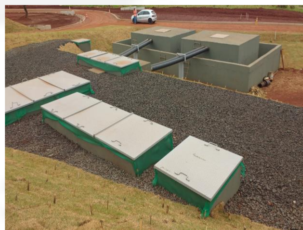
Foto 02. Unidade de Controle de Efluentes (UCE)
