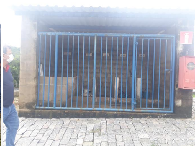
Foto 04: Central de armazenamento de resíduo sólido
