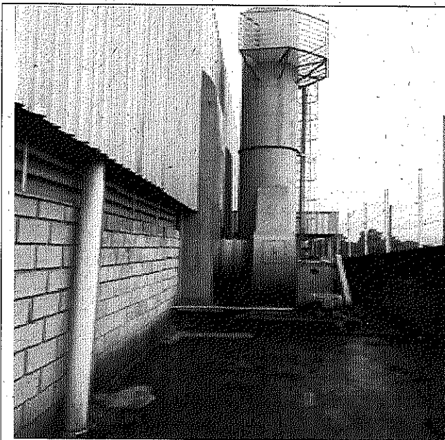
Fotos VI e VII – Fonte fixa – exaustão da mitigação da cabine de pintura e ETE que trata efluente sanitário gerado.
