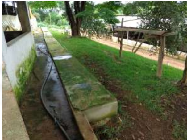
Foto 02. Canaletas de efluentes
