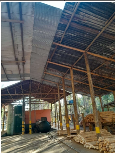
Foto 05: Adequação da usina de tratamento através da instalação de cobertura. Fonte: Informações Complementares entregues.
